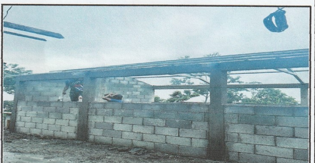
Foto 6: Estructura de techo del aula tipo portico
