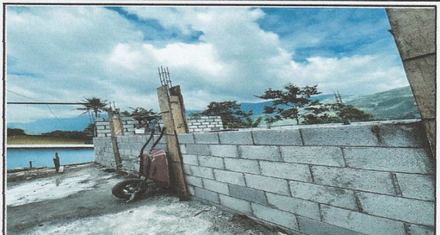
Foto 2: Formaletiendo comulmnas del aula tipo portico
