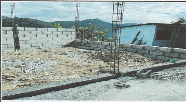
Foto 1: Cimiento del aula tipo portico
