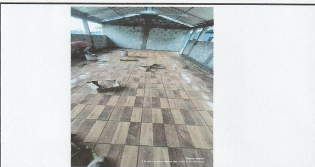
Foto 5: preparando espacio para el piso del aula tipo portico
