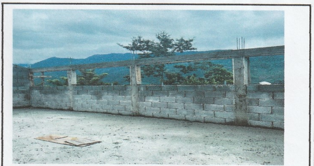
Foto 4: estructurando ventanales del aula tipo portico
