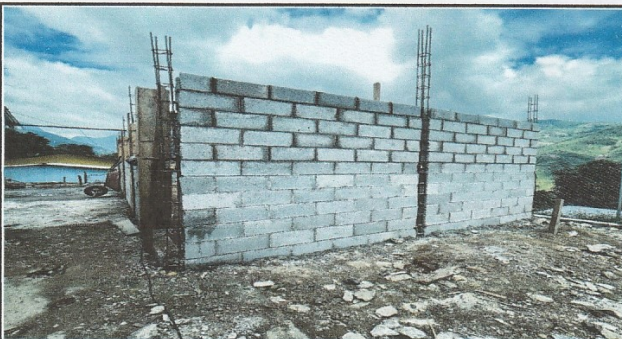
Foto 3: Levantado de pared del aula tipo portico
